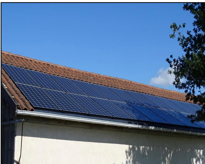
Pose de panneaux solaires, local technique des ateliers municipaux
