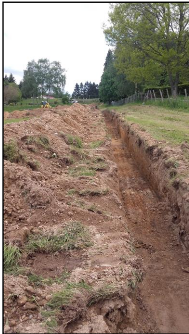
Tranchée pour pose panneaux photovoltaïques Etang LAMAUD-DESBORDES
